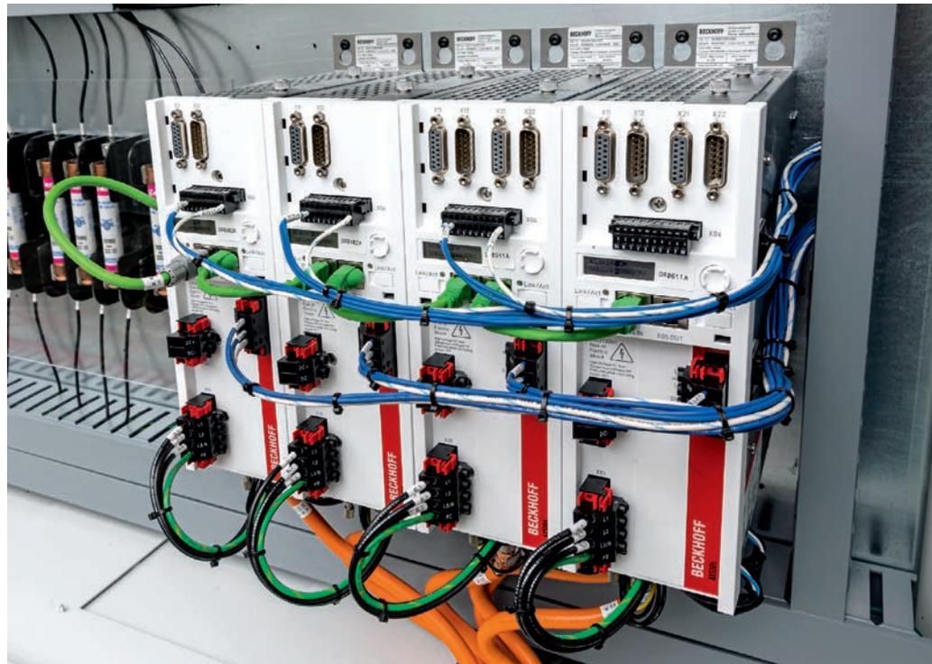
▲ Die Servoverstärker der Serie AX5000 von Beckhoff versorgen alle Bewegungsachsen über die platzsparende One Cable Technology, die Leistung und Positionsfeedback in einem Kabel bereitstellt.
