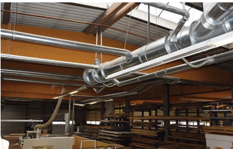
► Durch das Einrohrsystem ist die Sepas-Späneabsauganlage besonders flexibel.
