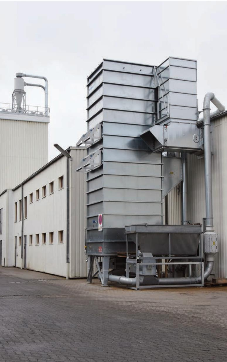
► Die Sepas-Späneabsauganlage mit einer Gesamtleistung von 40.000m<sup>3</sup>/h spart dem Unternehmen Energie. Auf dem 25 Meter hohen Spänebunker wurde von Scheuch Ligno ein Zyklon montiert.
