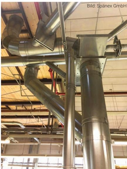
▲ In die Anschlussleitungen zu den Holzbearbeitungsmaschinen wurden automatisch öffnende und schließende Absperrschieber eingebaut.
