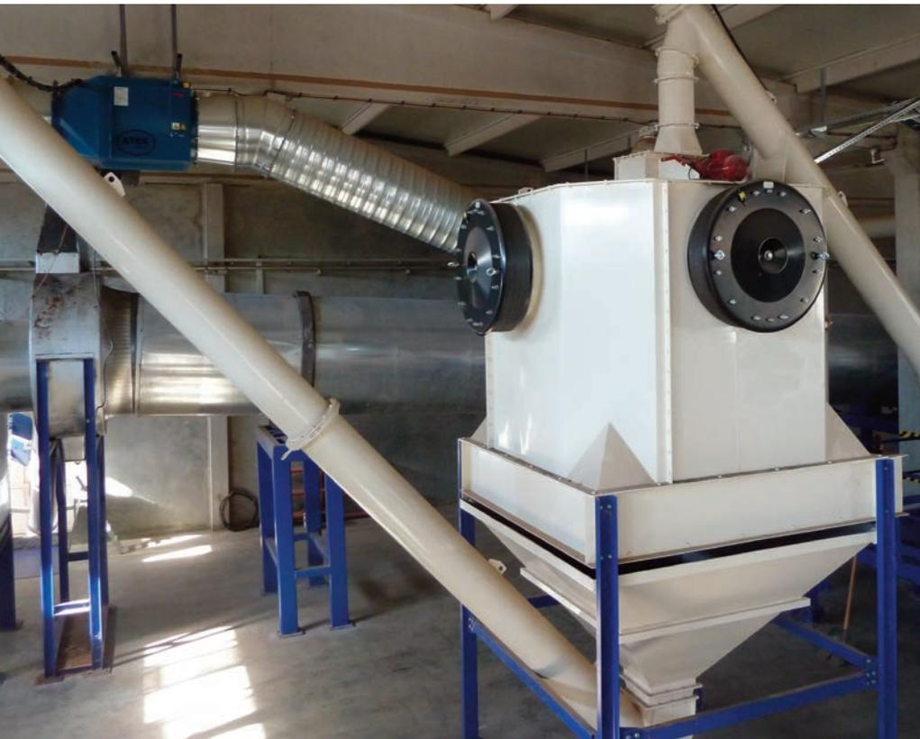
◀ Pellet Cooler mit flammenloser Druckentlastung: Bei Anlagen zur Holzpelletproduktion sind in der Regel Ventile zur flammenlosen Explosionsdruckentlastung das kosteneffiziente Mittel der Wahl.
