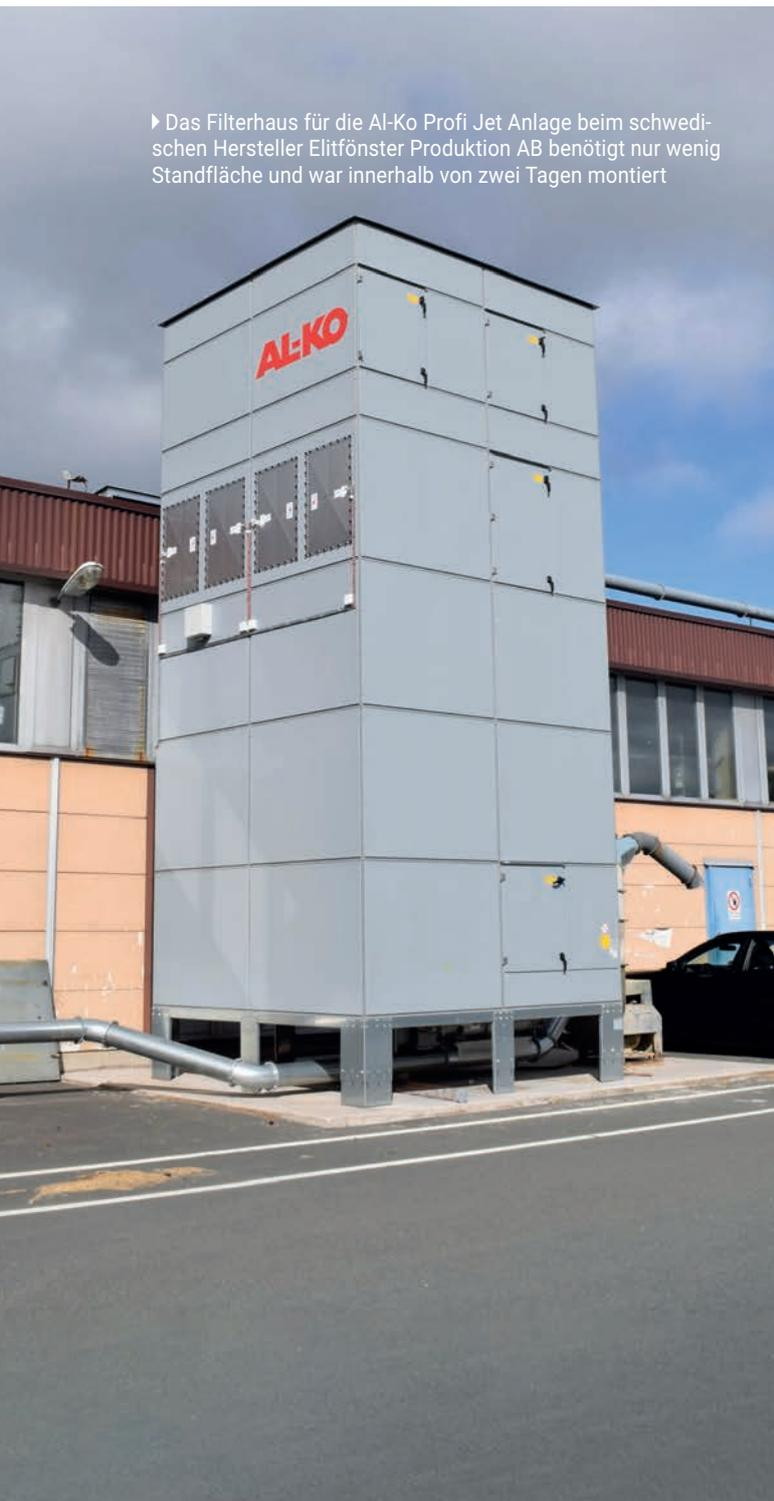
*Qualitativ hochwertige und energiesparende Fenster sind die Spezialität des schwedischen Herstellers Elitfönster Produktion AB in Vetlanda, knapp 190 Kilometer östlich von Göteborg. Der Fensterspezialist nutzt jetzt eine stationäre Systemfilteranlage von Al-Ko Extraction Technology.*
