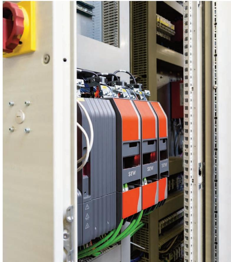
► Der kompakte Schaltschrank beinhaltet die Umrichter der Baureihe Movidrive modular Double MDDA. Sie steuern zwei Achsen – die Folienzuführung und den Palettentransport, damit eine Auf-synchronisierung stattfindet.
