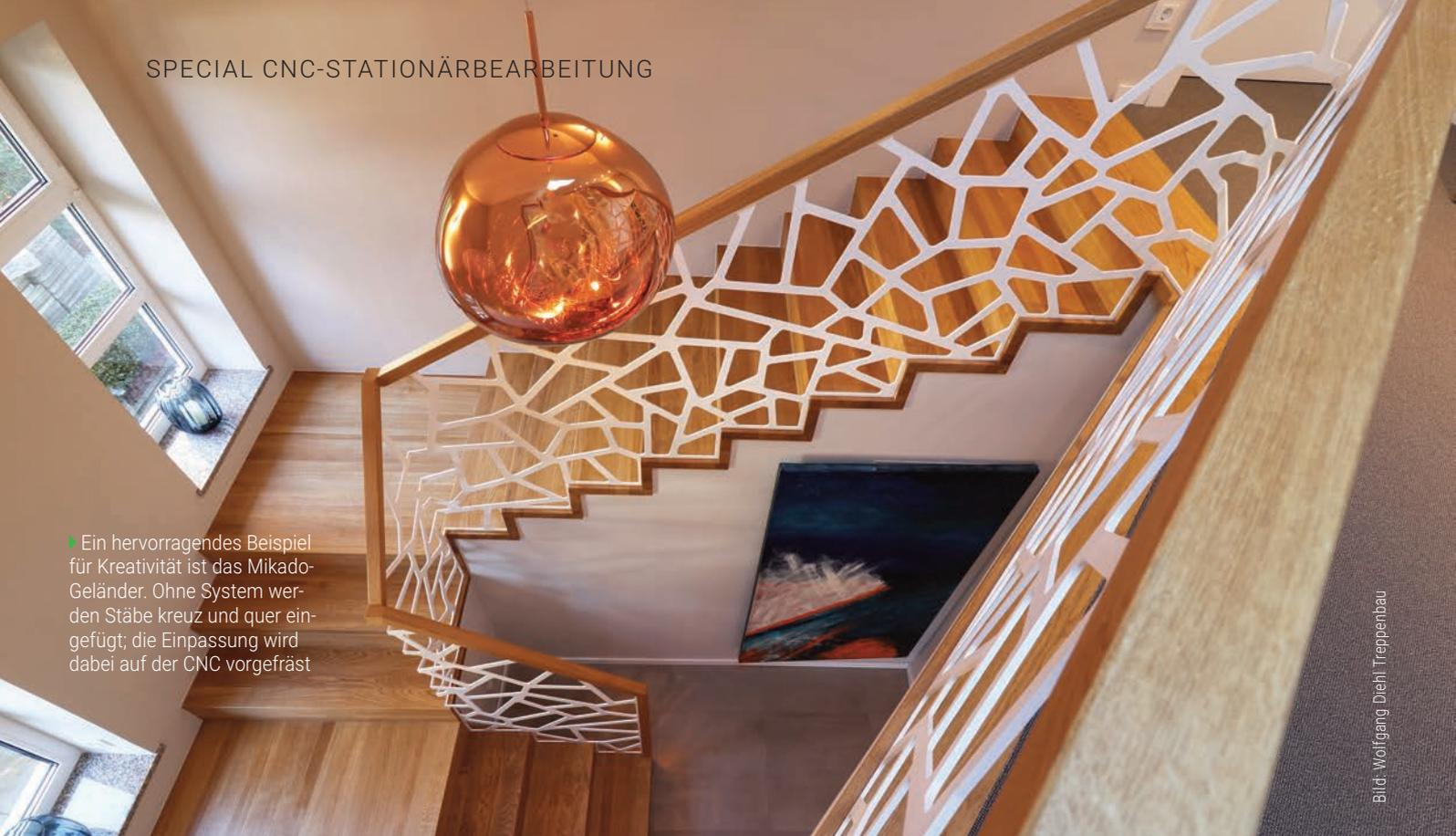
► Ein hervorragendes Beispiel für Kreativität ist das Mikado-Geländer. Ohne System werden Stäbe kreuz und quer eingefügt; die Einpassung wird dabei auf der CNC vorgefräst
