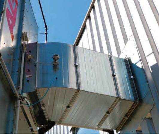
▲ Rückluftkanal mit Reststaubsensor
