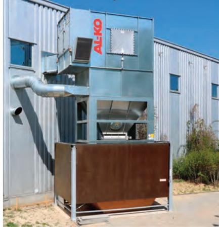
▲ Die zentrale Eco-Jet-Kompaktfilteranlage
