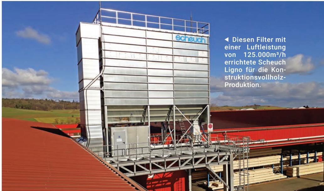
◀ Diesen Filter mit einer Luftleistung von 125.000m³/h errichtete Scheuch Ligno für die Konstruktionsvollholz-Produktion.
