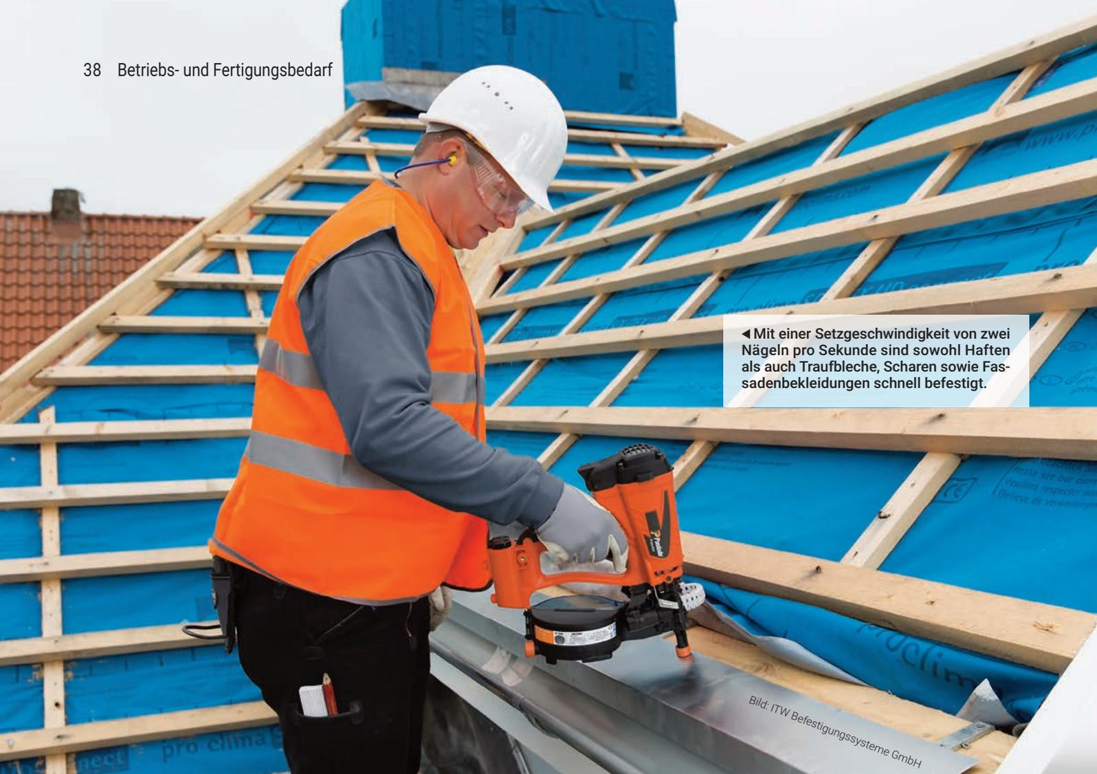
◀ Mit einer Setzgeschwindigkeit von zwei Nägeln pro Sekunde sind sowohl Haften als auch Traufbleche, Scharen sowie Fassadenbekleidungen schnell befestigt.
