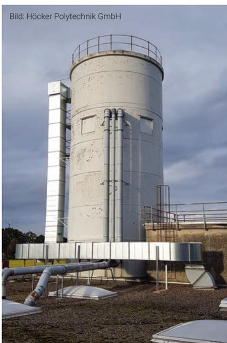
▲ Installierte Rückluftführung. Die wertvolle Wärmeenergie bleibt nun erhalten und reduziert die Heizkosten um 37,5%
